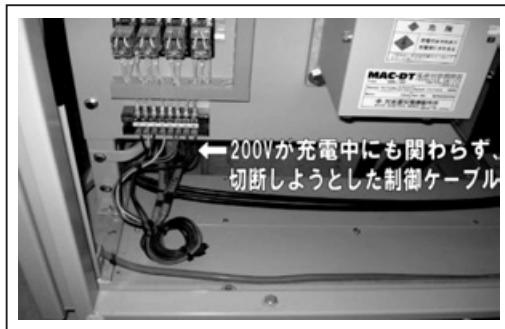
竣工後の状態
